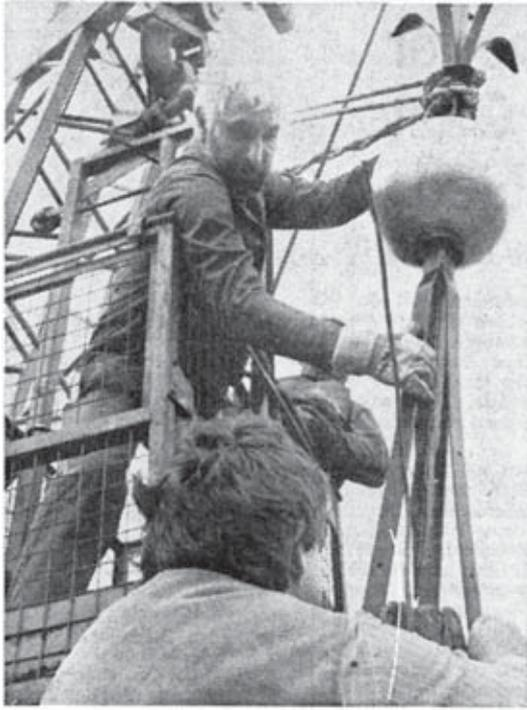
Nach dem „Einstecken“ werden die seitlichen Flacheisen verschraubt und zusätzliche Halteringe angebracht.
